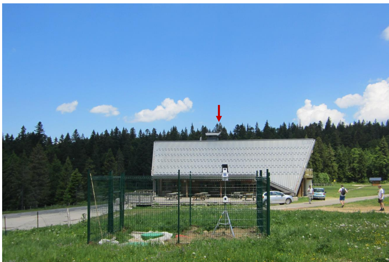
Vue vers le Nord (anémomètre sur le toit du bâtiment – flèche rouge)
