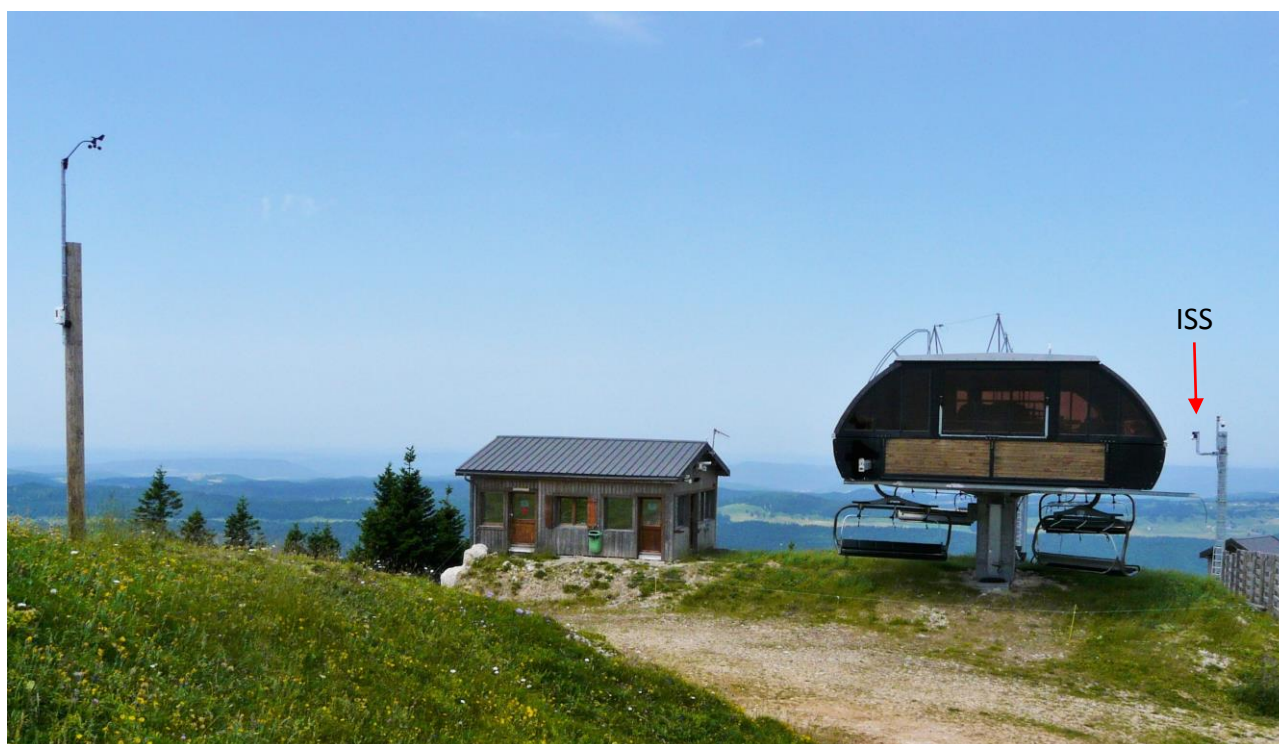
Vue d'ensemble – vers le Nord-Ouest
